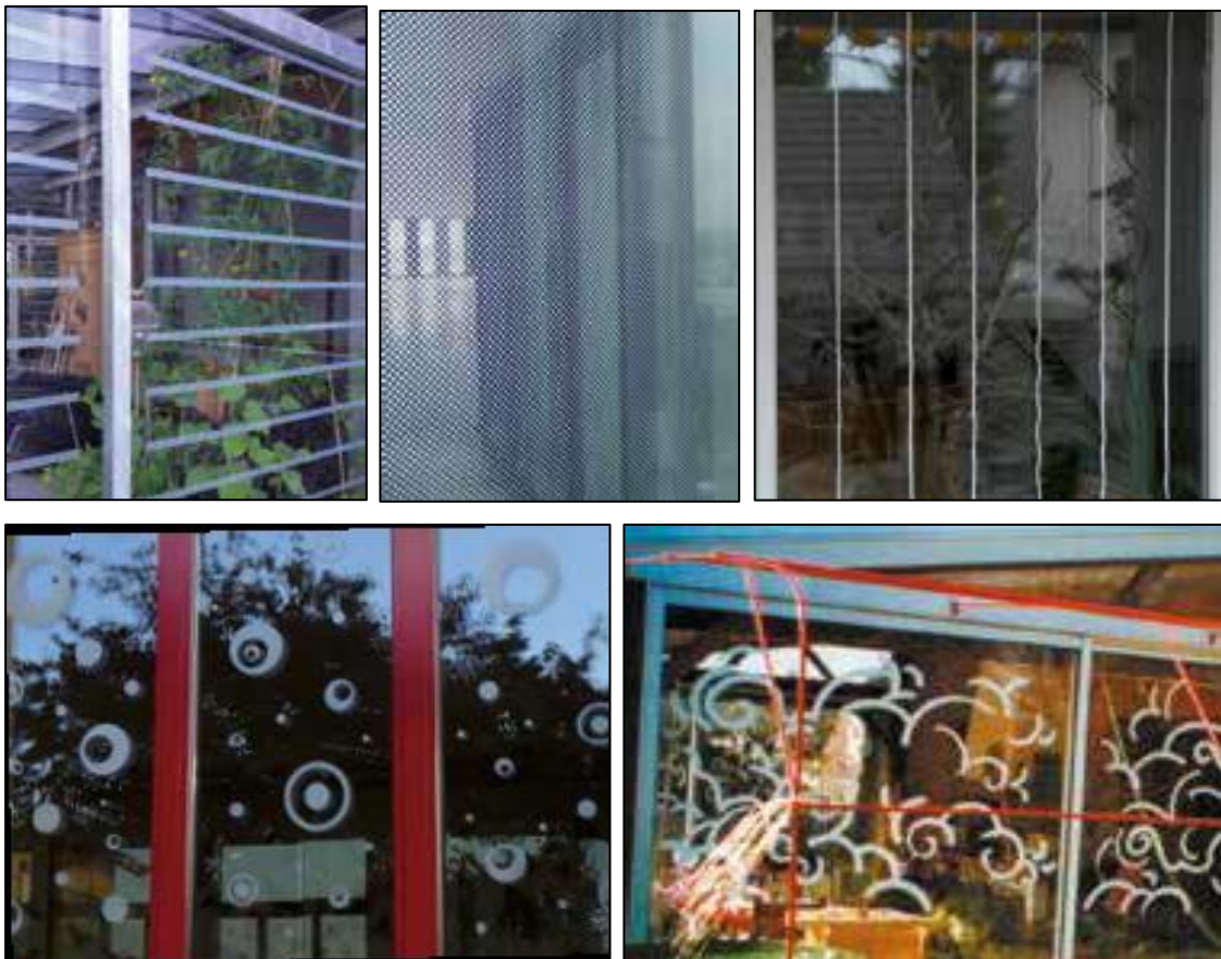
Abbildung 3: Beispiele für Markierungen aus Kristallfolie als Schutzmaßnahme gegen Vogelschlag (SCHMID 2016)
